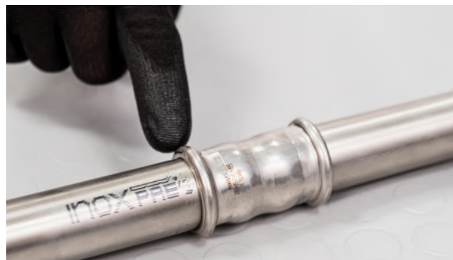
Figura 28 - Controllo della pressatura
