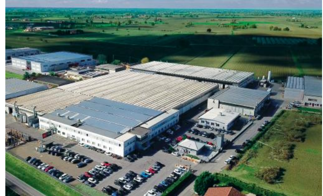
Figura 1 - Sede e stabilimento a Campitello
